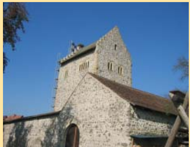
Arbeiten in schwindelnder Höhe: Neuer Storchhorst auf der Burganlage in Hilzingen-Riedheim. Foto: Rita Strieckmann.
